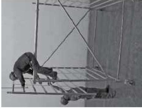
**Wskazówka:** Do montażu i demontażu przewidziane są pomosty pomocnicze. Po zakończeniu montażu i demontażu należy je usunąć. Według normy DIN4420-1 deski muszą mieć szerokość nie mniejszą niż 24 cm a grubość przynajmniej 4,5 cm. Do zamocowania pomostu deski muszą być dłuższe od rusztowania o przynajmniej 20 cm z każdej strony.
